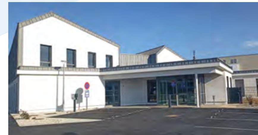
Bâtiment Telkes, vue de l'entrée de l'agence clientèle
