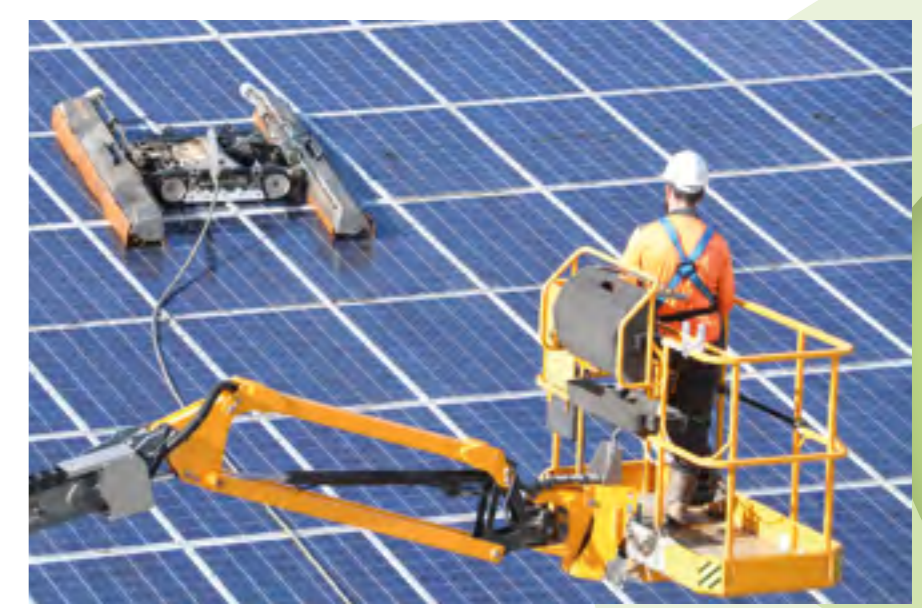
Nettoyage de l'ombrière du siège social de SÉOLIS
