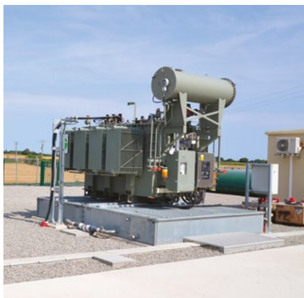
Un des deux transformateurs d'une puissance de 15 MVA chacun.
